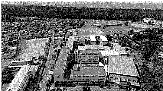
本校校舎全景（ドローンにて撮影）
