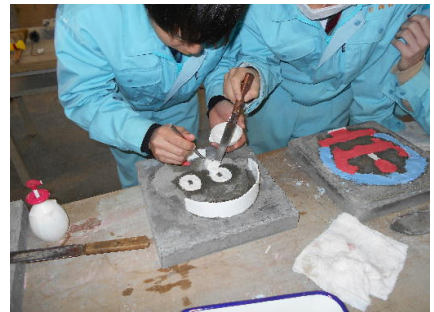
カラーコンクリートの打設
