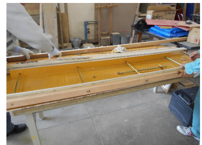
型枠の組み立て
