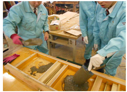
コンクリートの打設
